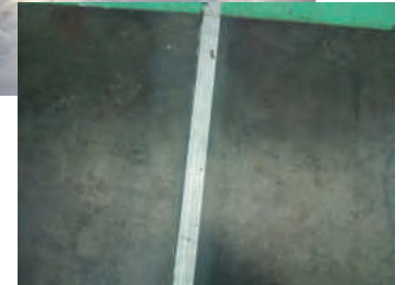
黒皮鉄板アルミテープ養生例 Aluminum tape on black steel plate
